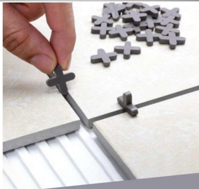
COD: NT1990-3 SEPARADOR CERAMICA 3MM
